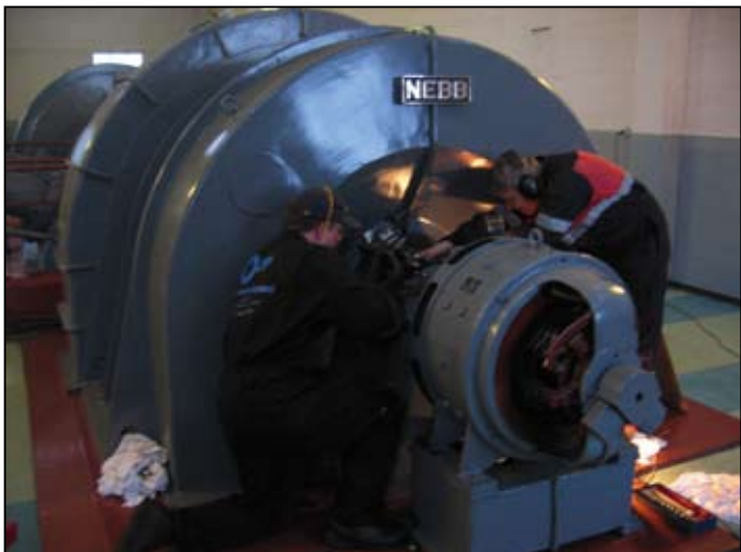
Dreining av sleperinger, gen.2, Verma
