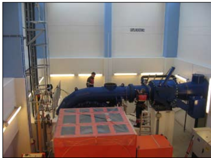
Vedlikehold av generator og turbin, Berild
